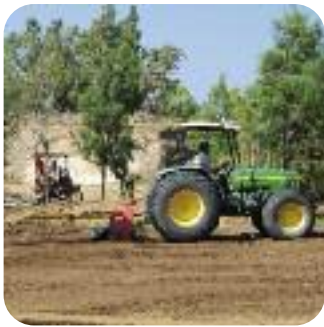
Incorporación de TerraCottem® Turf en la capa de enraizamiento
