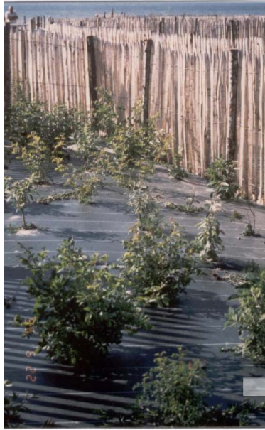
Foto 1 : Vlak na aanplanting. Een 8cm dikke grondlaag werd aangebracht om te verhinderen dat het onderliggende zand zich verder zou verplaatsen. Het geheel werd bedekt onder een plasticfolie om onkruidvorming te beperken.
