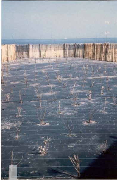
Foto 1 : Vlak na aanplanting. Een 8cm dikke grondlaag werd aangebracht om te verhinderen dat het onderliggende zand zich verder zou verplaatsen. Het geheel werd bedekt onder een plasticfolie om onkruidvorming te beperken.
