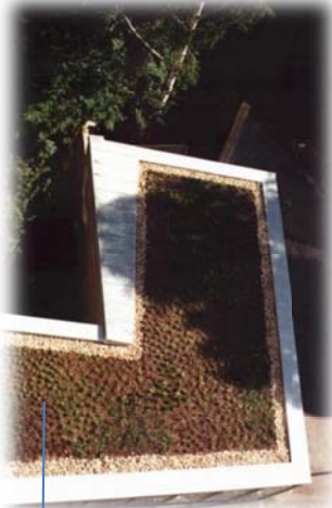
Net na aanleg (Diepte wortelzone: 20cm)
