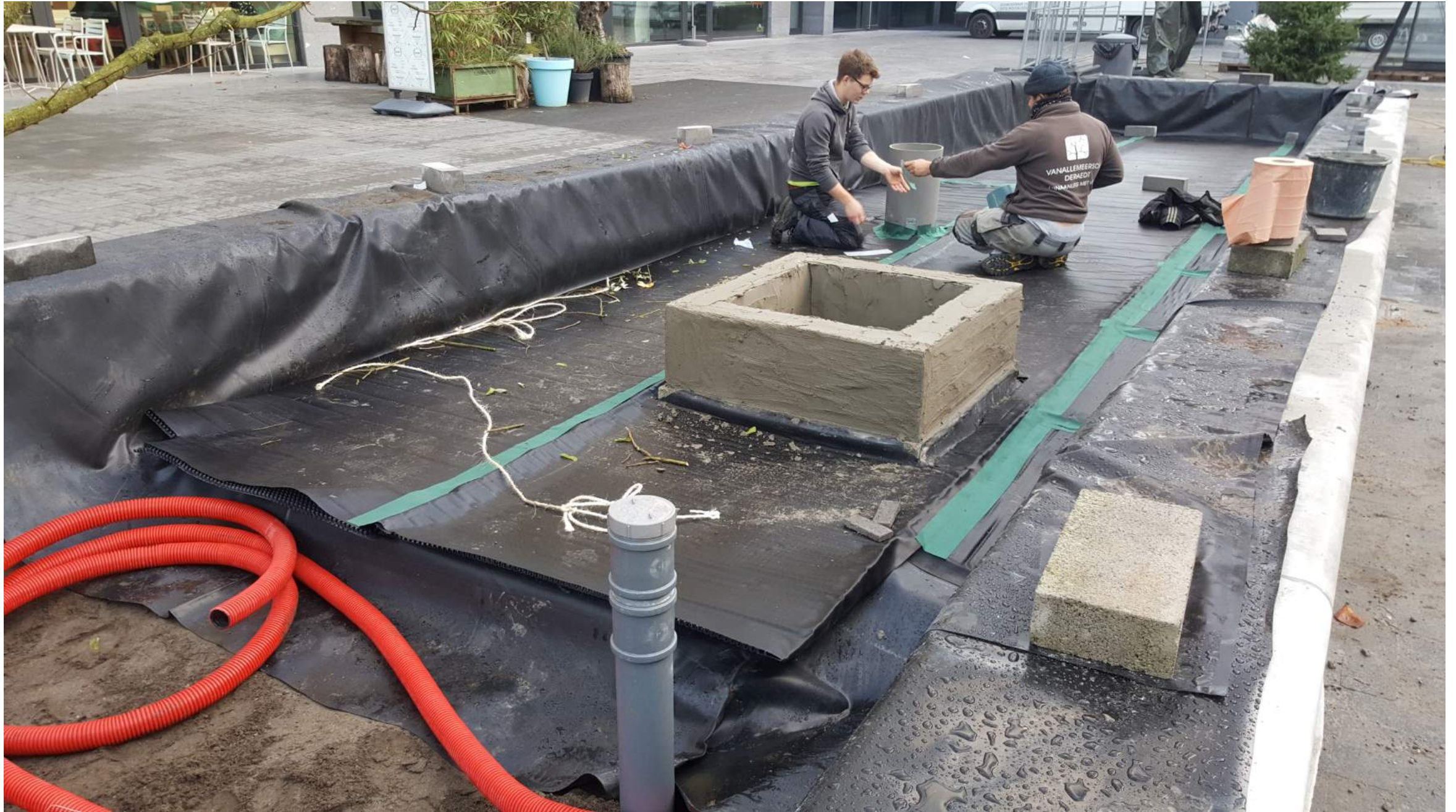
Aanbrengen van wortelvaste folie en drainagemat
